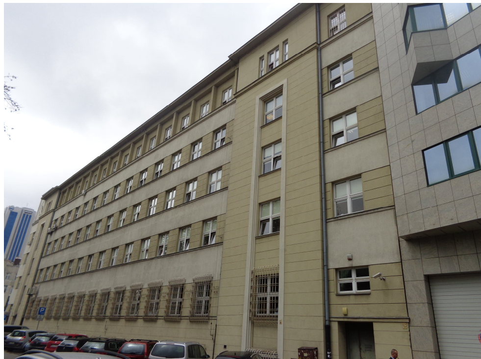
Elewacja od ul. Nowogrodzkiej
