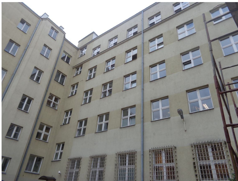
Elewacja od podwórza
