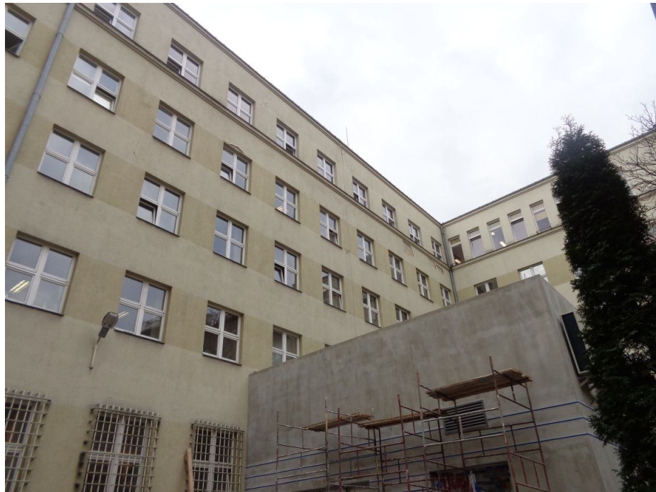
Elewacja od podwórza
