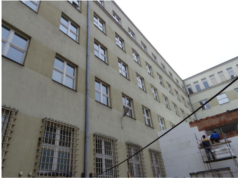
Elewacja od podwórza
