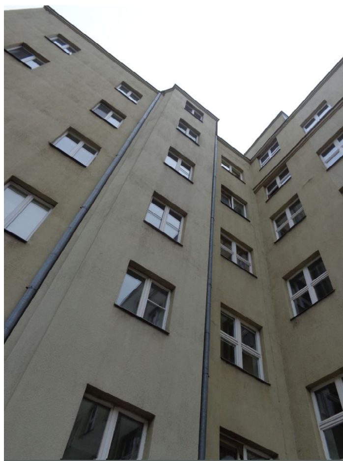
Elewacja od podwórza
