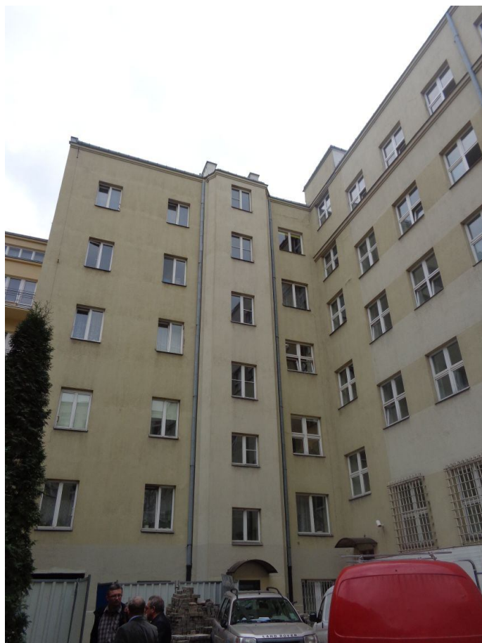
Elewacja od podwórza
