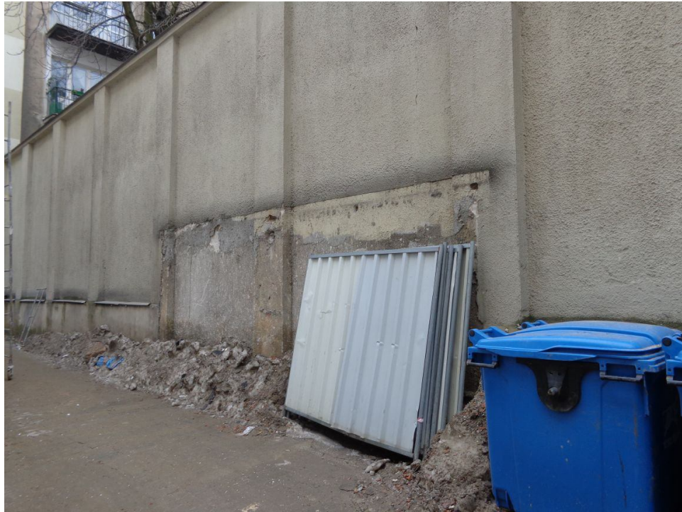
W podwórzu przewidziany do remontu mur - położony na granicy posesji
