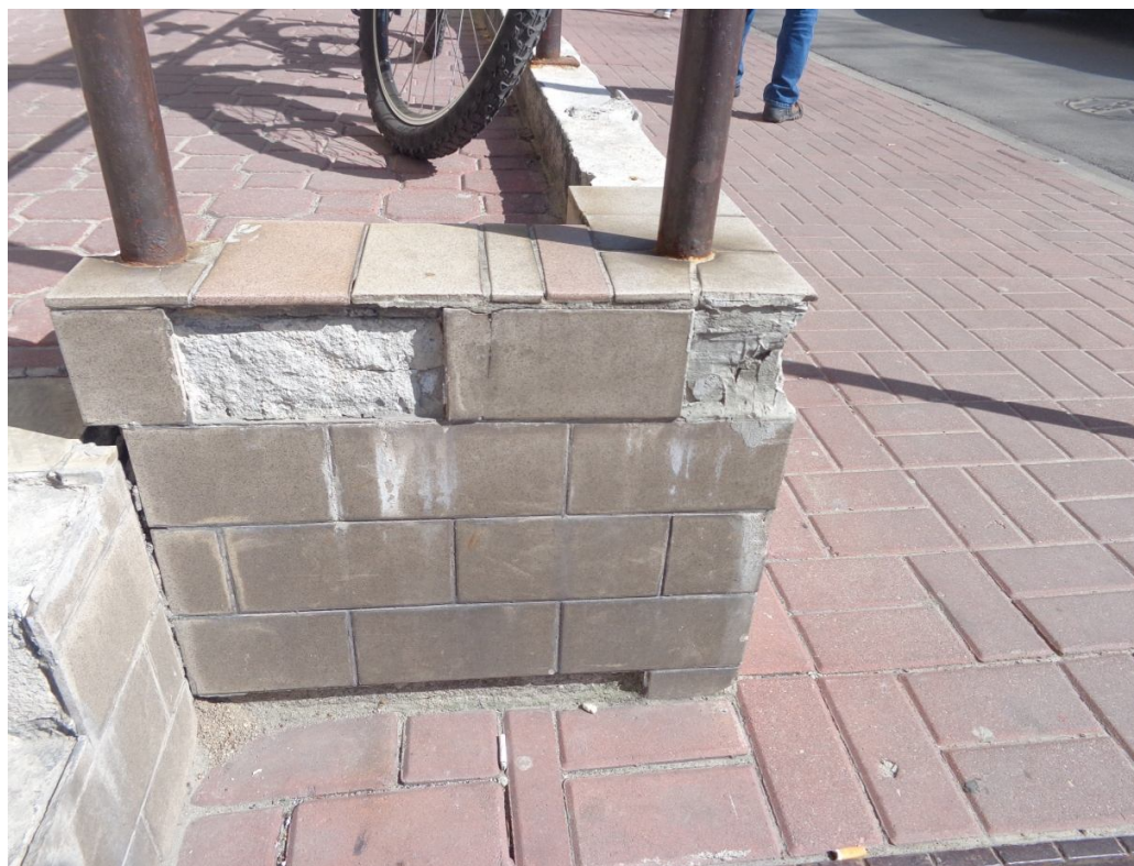
Odspojone okładziny pochylni dla niepełnosprawnych od ul. Nowogrodzkiej
