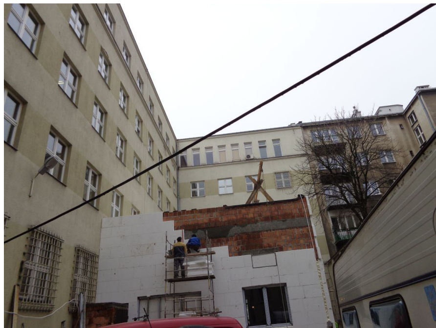
Elewacja od podwórza
